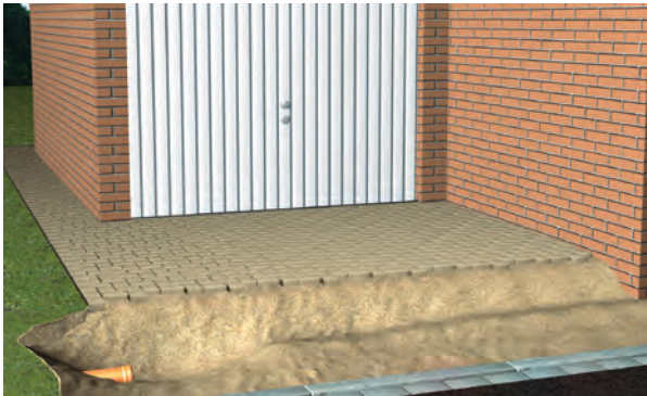
1. Rinnenstrangverlauf, Anschlusspunkt und Belastungsklasse festlegen.
