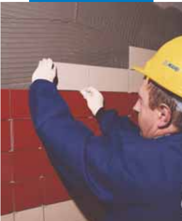
Polaganje keramičkih pločica na zid, od vrha prema dnu
