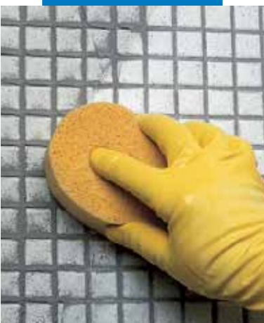
Završna obrada staklenog mozaika sunderom
