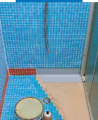
Hidroizolacija i lepljenje u prefabrizovanom kupatilu
