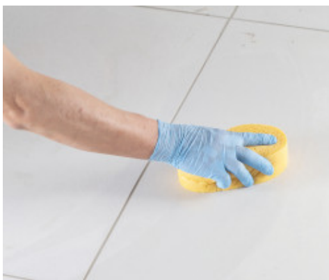
Čišćenje i završna obrada spojeva tvrdim celuloznim sunderom.
