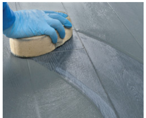
Čišćenje i završna obrada spojeva tvrdim celuloznim sunđerom.
