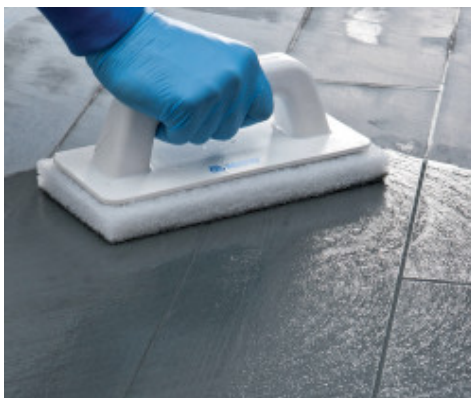
Čišćenje spojeva ScotchBrite® sunđerom (kada je proizvod polutvrd).
