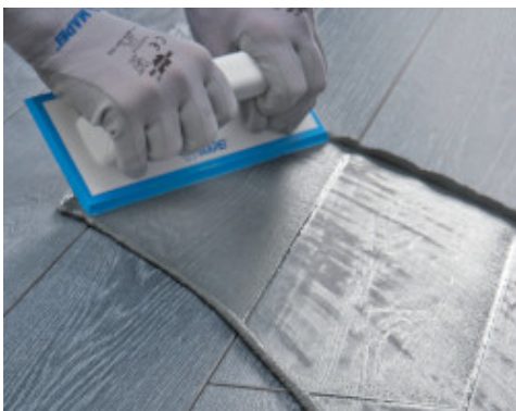
Nanošenje mase Ultracolor Plus na keramičke pločice sa efektom drveta gumenom gletericom.
